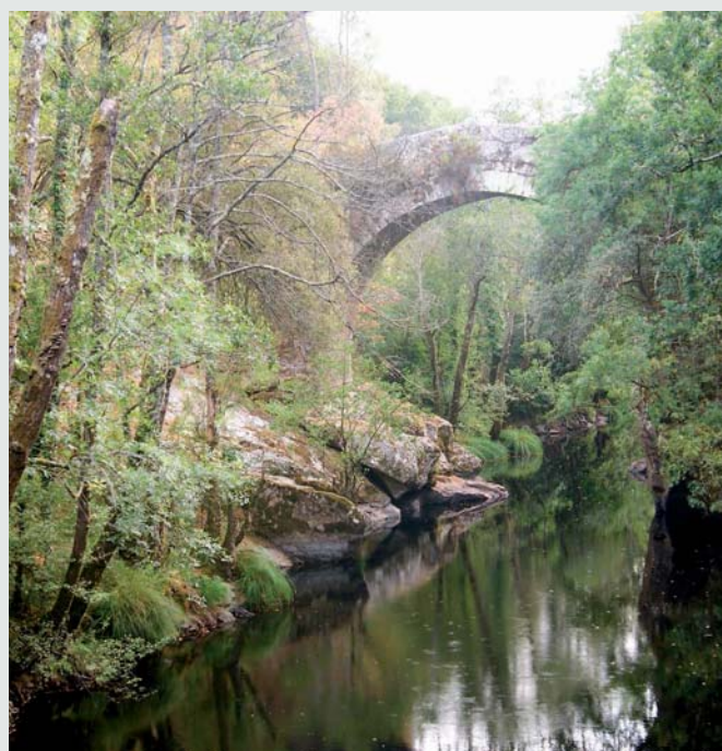
Vista xeral da Ponte desde o merendeiro da fábrica da luz
