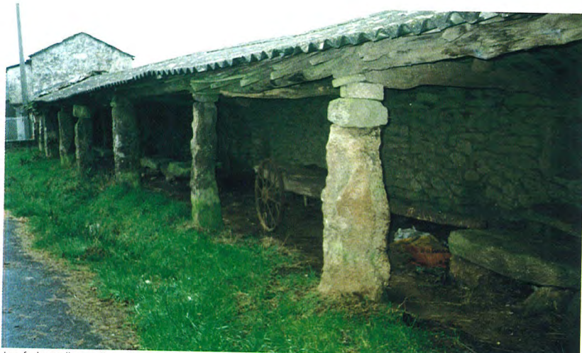
Las ferias gallegas dieron lugar a estos galpones en los que se cobijaban los asistentes a las mismas. Quedan pocos en Galicia, en este camino los encontraremos en Bouzas (de Ourense a Oseira) y en A Gouxa (camino de Dozón).
